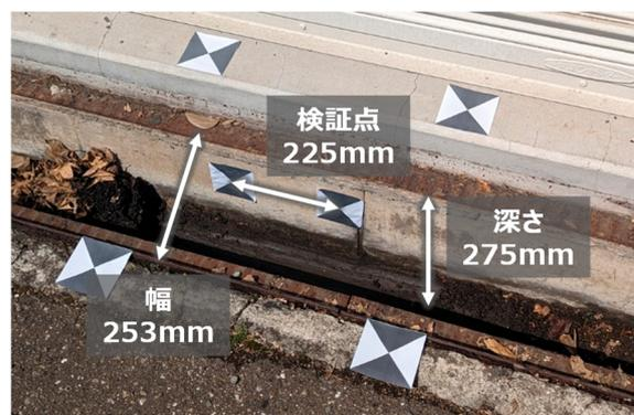
図1: 計測対象の側溝と各部の寸法
